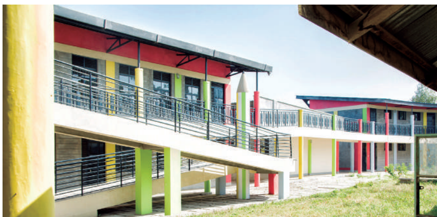
Escuela primaria pública construida como parte del proyecto de desarrollo urbano para la ciudad de Kisumu, que desde 2012 financia AFD en Kenia.
